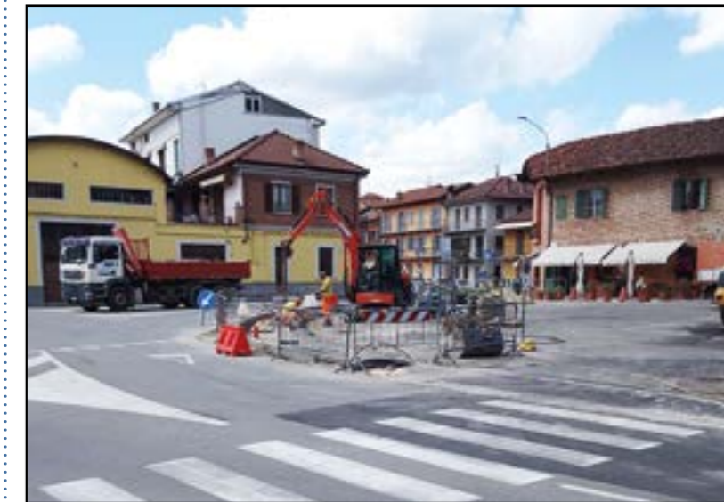
Lavori in corso: Piazza Divisione Alpina Cuneense
