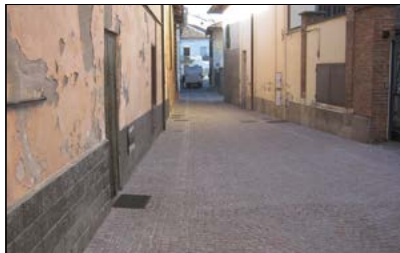
Lavori eseguiti in Via Alois
