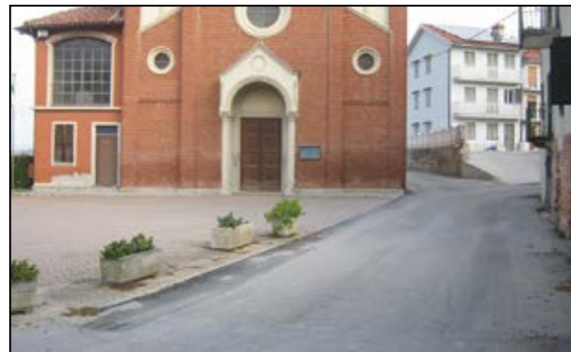
Lavori manto stradale Madonna dei Cavalli
