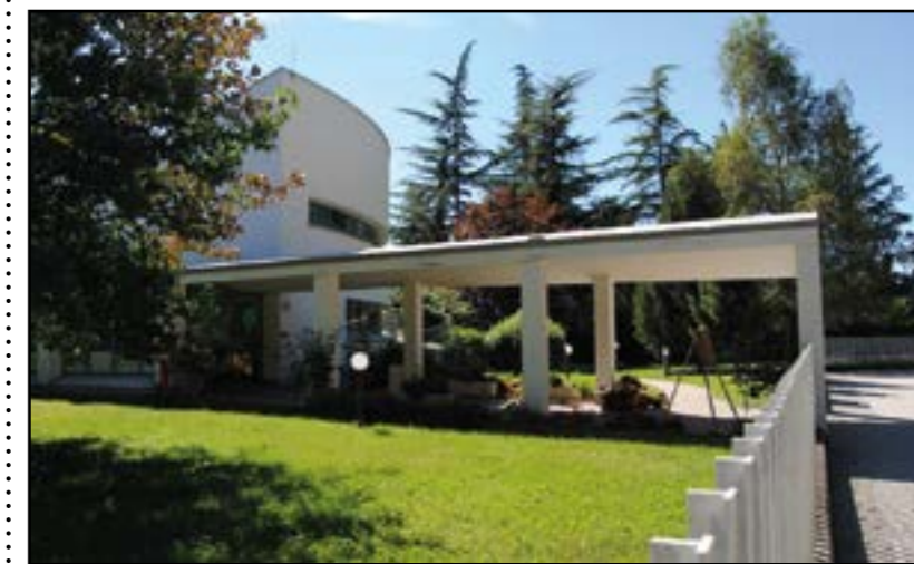
Interventi di risanamento superfici esterne
