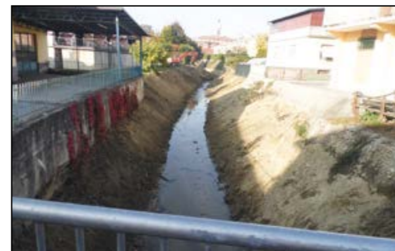
Sistemazione Rio Canale
