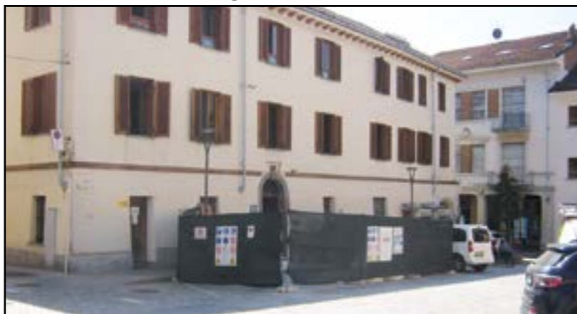
Ristrutturazione Locali della ex Pretura
