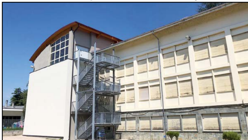
Lavori di efficientamento edificio scolastico
