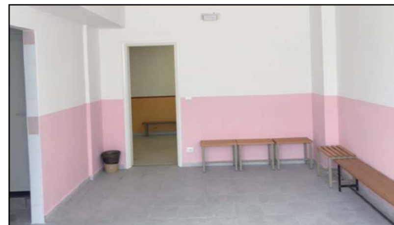
Bagni Spogliatoi Scuola
