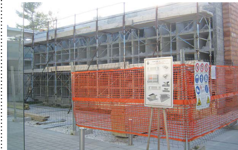
Cimitero Comunale: lavori in corso
