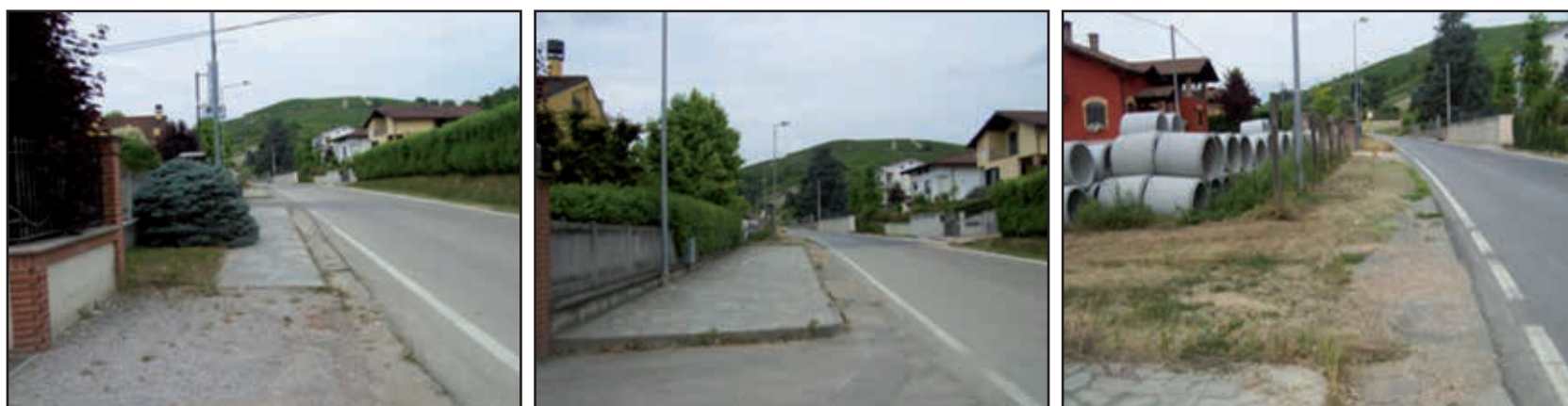
PARTICOLARI DEL NUOVO PROGETTO IN CORSO D'OPERA
