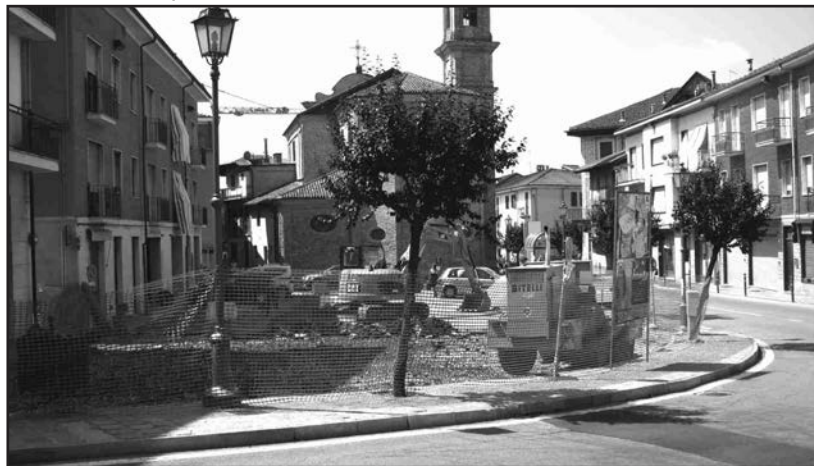
Piazza Marconi: lavori in corso
